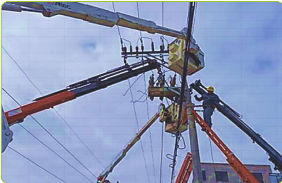
Instalación de reconectador en alimentador Licán, Chimborazo E.E. Riobamba
